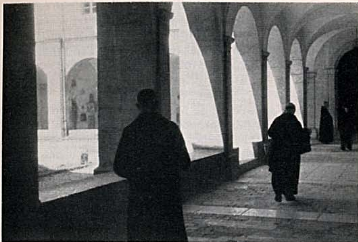
A l'ombre du cloître d'Hautecombe
